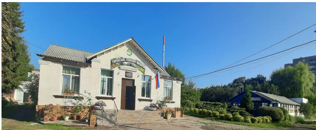
Рисунок 5. Фасад административно-учебного здания РГСЮН. Фото Е.Е. Харитоновой, 2025 г.
